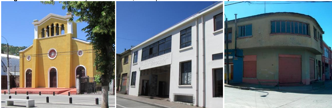
Fotografía N° 3: Iglesia Parroquial Sn Rosendo, Municipalidad de San Rosendo y Casa Eltit
