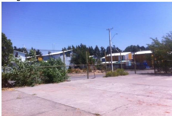
Fotografía 10: Multicancha en calle Irarrázaval
