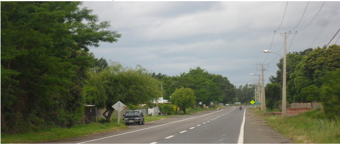
CONSERVACION RUTA Q-45, SECTOR LOS ANGELES-ANTUCO 2020 -2022 PLAN RECUPERACION
