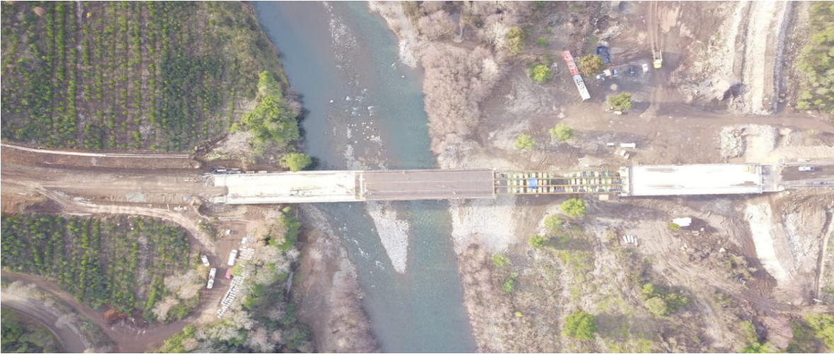
REPOSICIÓN PUENTE DUQUECO, PROVINCIA DE BIO BIO.
