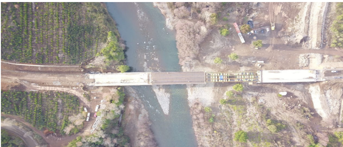
REPOSICIÓN PUENTE DUQUECO, PROVINCIA DE BIO BIO.
