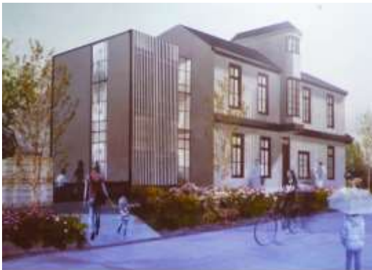
RESTAURACION CASONA EYHERAMENDY DE LOS ÁLAMOS Solicitado 2024: M$ 687.991
