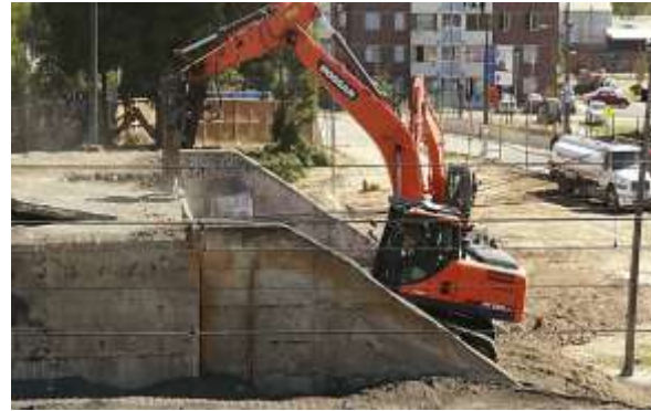
CONSTRUCCION CORREDOR TRANSP. PUBLICO CORONEL: LABORES - P. AGUIRRE Solicitado 2024: M$ 3.846.992
