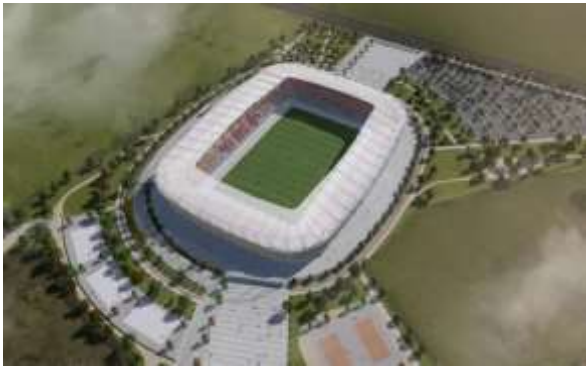
CONSTRUCCION ESTADIO COMUNA DE LOS ÁNGELES
