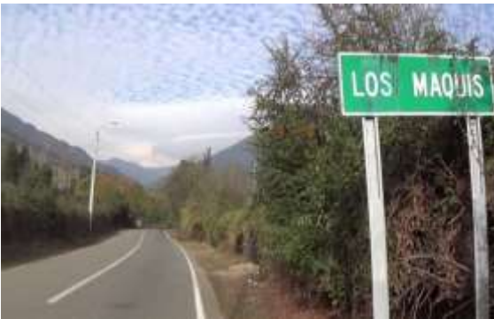
MEJORAMIENTO RUTA P-721; P-722 SECTOR TIRUA - LONCOTRIPAY - LOS MAQUIS Sectorial Obras Públicas (Dirección de Vialidad) Solicitado 2024: M$ 3.000.000
