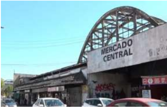
REPOSICION MERCADO MUNICIPAL DE LA CIUDAD DE CONCEPCION Solicitado 2024: M$ 5.000.000
