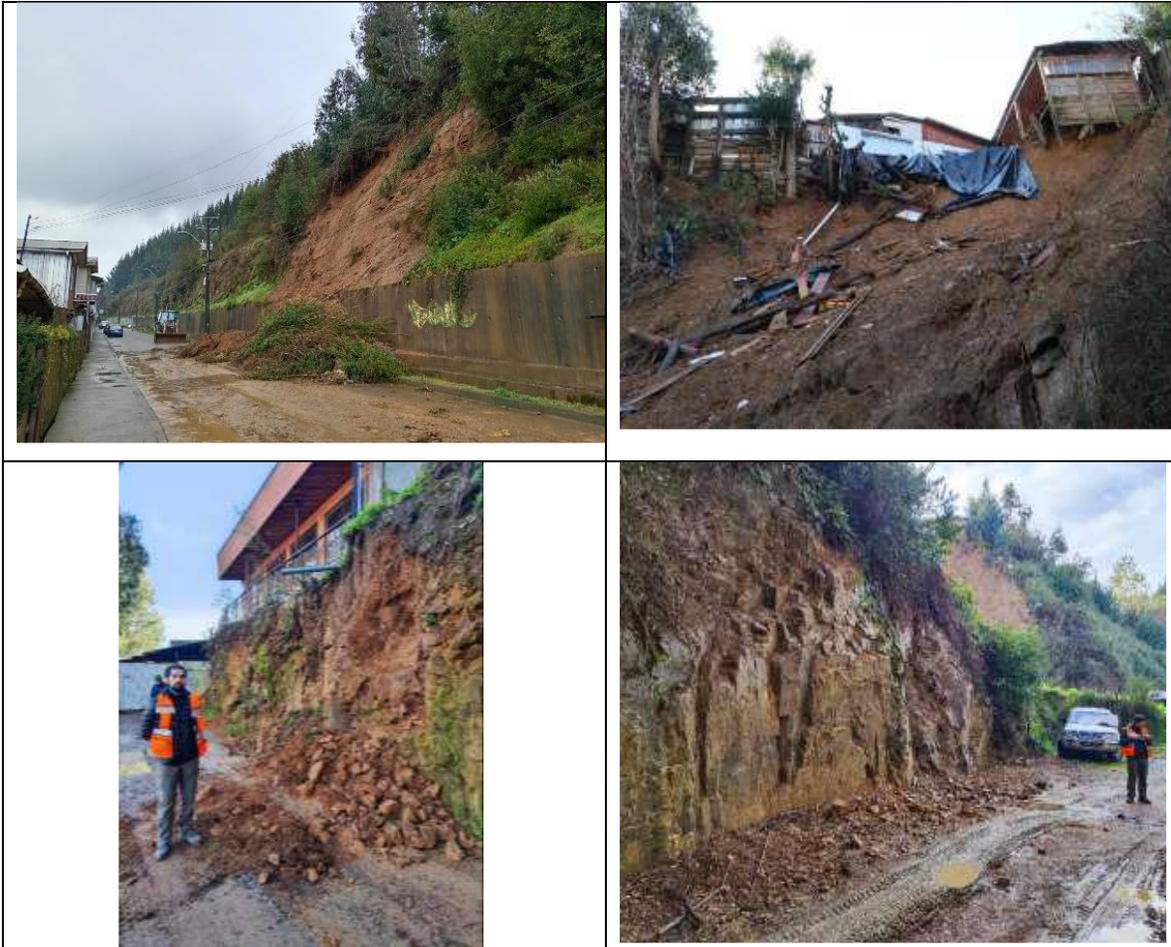
**Figura 24.** Fotografías de puntos de deslizamientos de tierra post temporal de 2024. a) Deslizamiento de suelo en Calle Arauco, pie del talud Diego Portales. B) Remoción en masa de tipo Deslizamiento de suelo observada el 19 de junio de 2024. C) Remoción en masa de tipo Caída de rocas observada el 19 de junio de 2024
